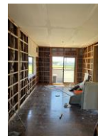
工事中 LDK 壁・天井を 撤去して 断熱材を 入れ替えます
