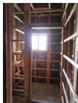
工事中 壁・天井 を撤去
