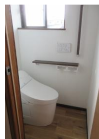
After トイレ 節水、パリアフリーに改修
