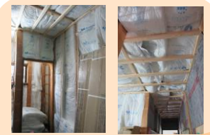
洗面・トイレ・ロカも 高性能断熱材に取替え 断熱強化!
