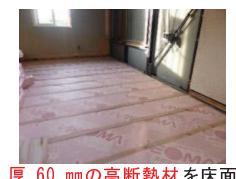
厚60mmの高断熱材を床面
