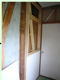
耐震ボード貼り
