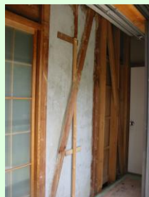
既設壁の撤去
