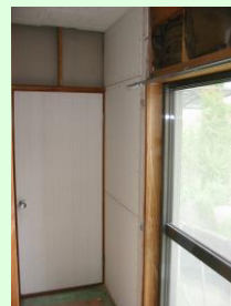
耐震ボード貼り
