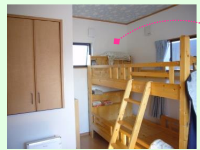
風通りが悪いのが悩みだったので、北側の収納を移設し、窓を取り付けました。
