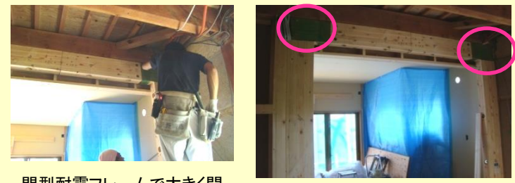
構造体の継ぎ目は、金物施工と包帯でしっかり固定します
