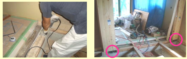
基礎にしっかりと固定・既設柱にもボルトで固定
