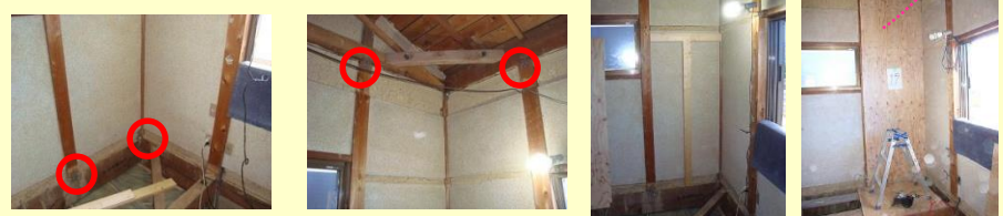
柱の根元と上部に耐震金物を取付け
