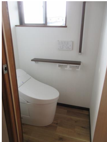
After 既設トイレのサイズのままです节水・段差解消・手すりの設置と性能がアップ
