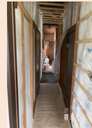
水廻りと寝室が近い為壁を遮音施工して音を緩和
