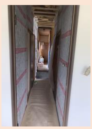
水廻りと寝室が近い為壁を遮音施工して音を緩和
