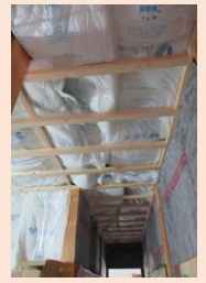
水廻りと寝室が近い為壁を遮音施工して音を緩和
