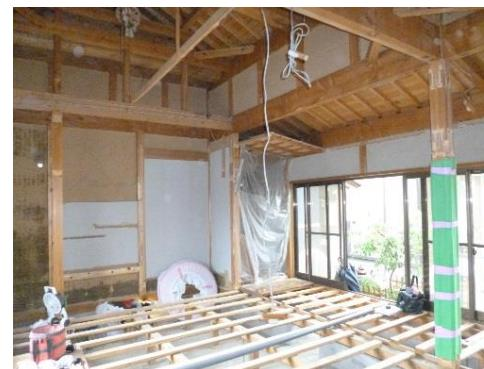
内装は全体に撤去して構造体の強化・断熱性能のアップをして、空間の変革リフォームをしていきます
