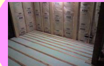
床下には断熱材を入れて 下からの寒さを軽減
