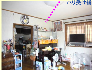
壁・柱撤去後の上部 ハリ受け補強
