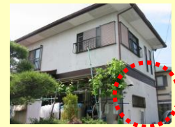
リフォーム 既存上から下地を組みガルバリウム鋼板サイディングを貼って外壁をリフォーム。窓も新しく取り替えました。
