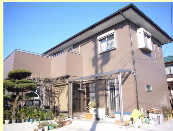
リフォーム 既存上から下地を組みガルバリウム鋼板サイディングを貼って外壁をリフォーム。窓も新しく取り替えました。
