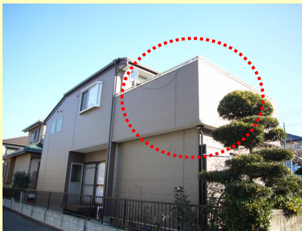
リフォーム 屋根を撤去して、バルコニーに改修。
