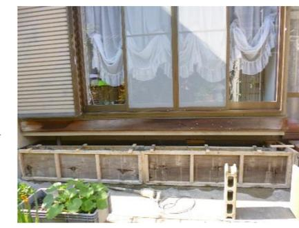
工事中：出窓下に基礎を造形～床造作・窓取り替え
