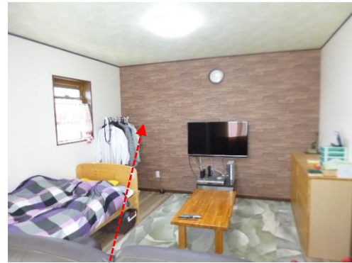
⑤After 開口だった部分を全面壁として耐震壁として可溶化
