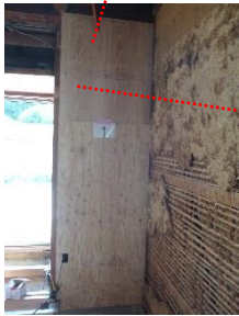
耐震工事中 床の間横の壁
